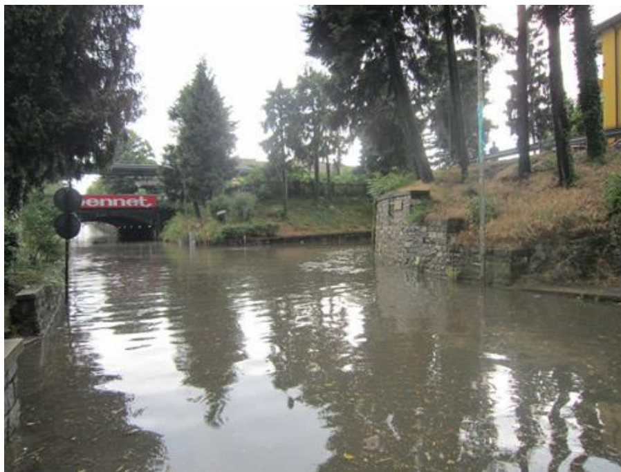
Esempio di allagamento del sottopasso di via Tasso in evidenza l'area interessata dall'evento
