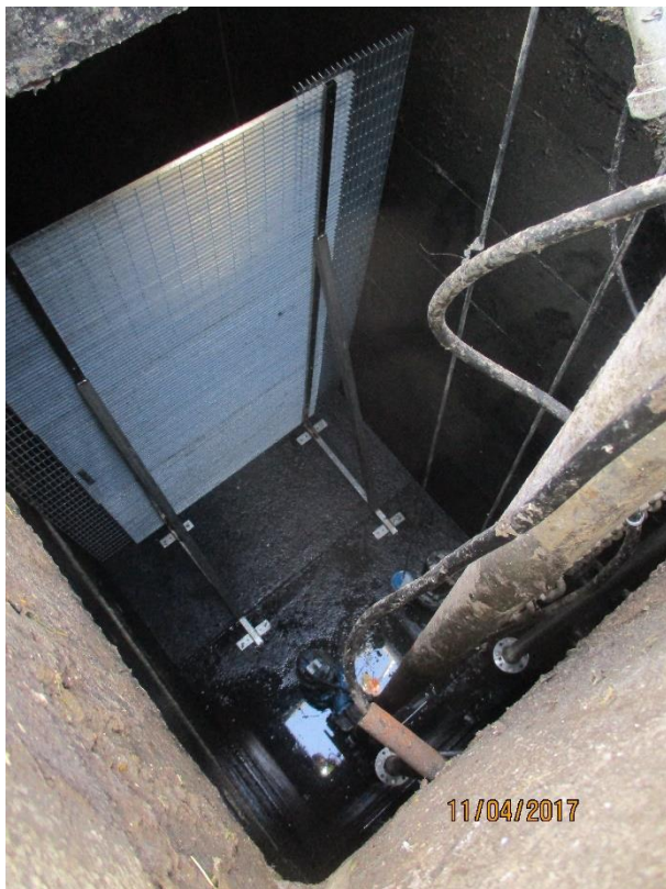
Esempio di sistema di grigliatura per impianti ad elevato flusso di reflui
