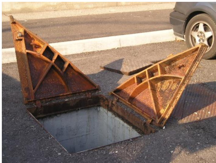
Esempio di pozzetti per l'interconnessione elettrica
