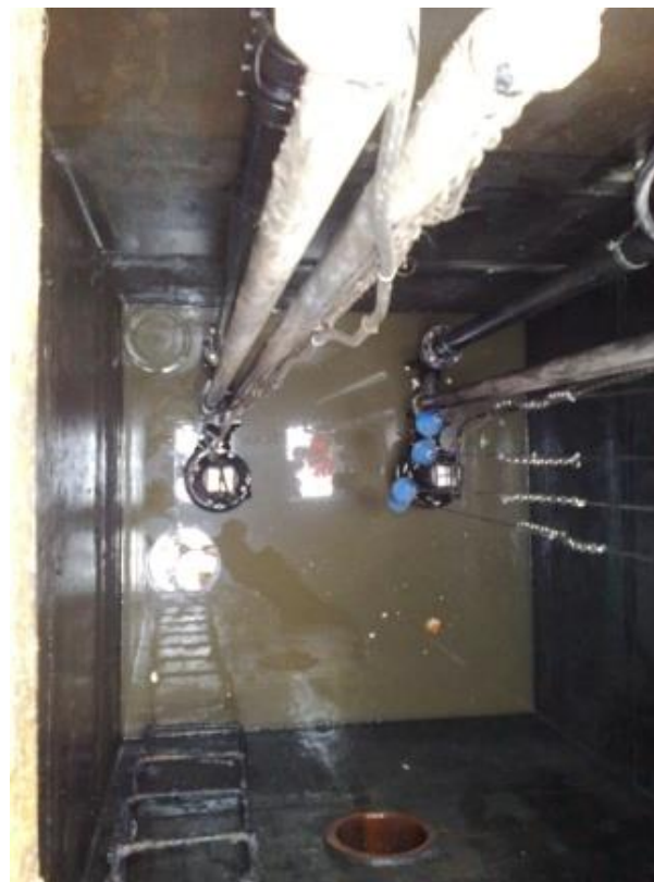
Esempio di corretta installazione dei cavi elettrici
