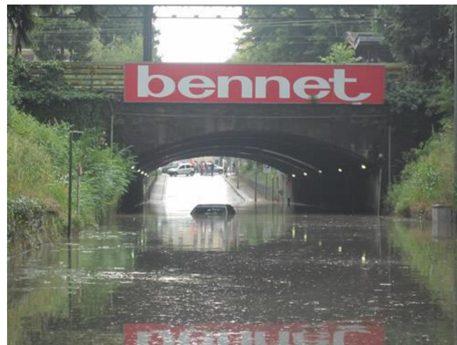
Esempio di allagamento del sottopasso di via Tasso prima dell'installazione del sistema di allarme ancora non in gestione ad Alfa
