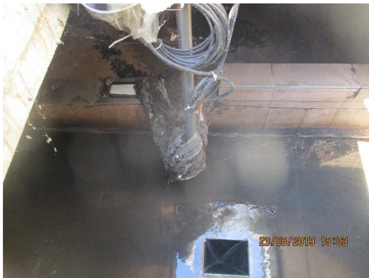
Esempio di trovanti tessili rinvenuti in uno scolmatore
