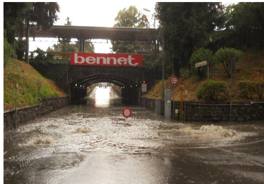
Esempio di allagamento del sottopasso di via Tasso in evidenza la fuoriuscita violenta dei reflui dai pozzetti fognari
