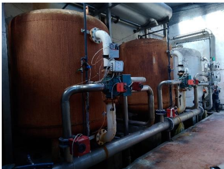
Figura 3.2. Locale filtri a sabbia.
